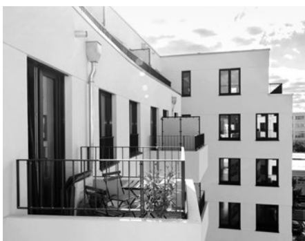
Der Neubau der Gewobag in der Kieffholzstraße besteht aus 98 Wohnungen, von denen 21 gefördert wurden. Bezugsfertigkeitsdatum war der 01.10.2015.
